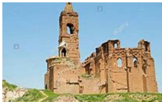
Une des nombreuses églises détruites par les communistes espagnols en 1936
